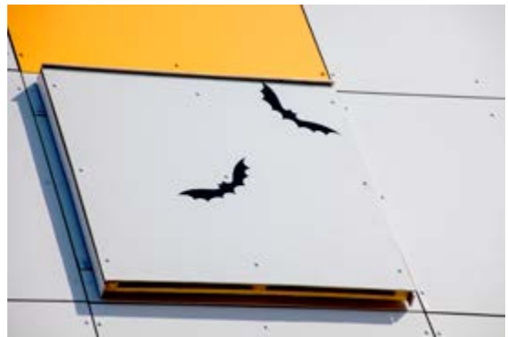
Die ausgezeichneten Quartiere für die Fledermäuse sind in der enercase Außenfassade integriert.
